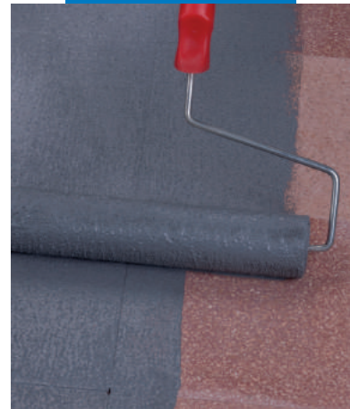
Aplicación de Eco Prim Grip con rodillo sobre viejo pavimento de terrazo
