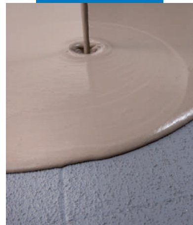
Aplicación del enlucido autonivelante Ultraplan sobre Eco Prim Grip seco y aplicado sobre un viejo pavimento
