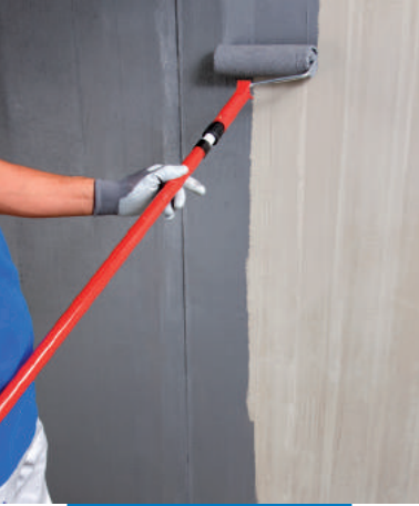
Aplicación de Eco Prim Grip a rodillo sobre un soporte de hormigón
