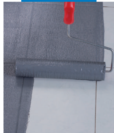
Aplicación con rodillo de Eco Prim Grip sobre pavimento preexistente de baldosas de gres porcelánico
